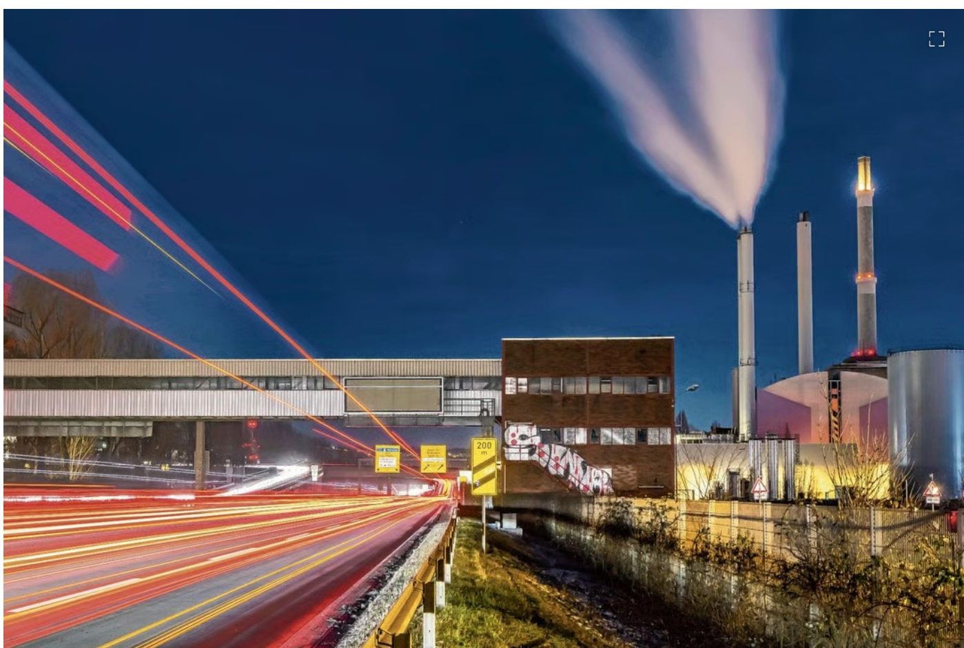
EnBW-Anlage in Stuttgart: Gaskraftwerke und Batteriespeicher sollen künftig einspringen, wenn zu wenig regenerative Energie produziert wird. Foto: IMAGO/Arnulf Hettrich
